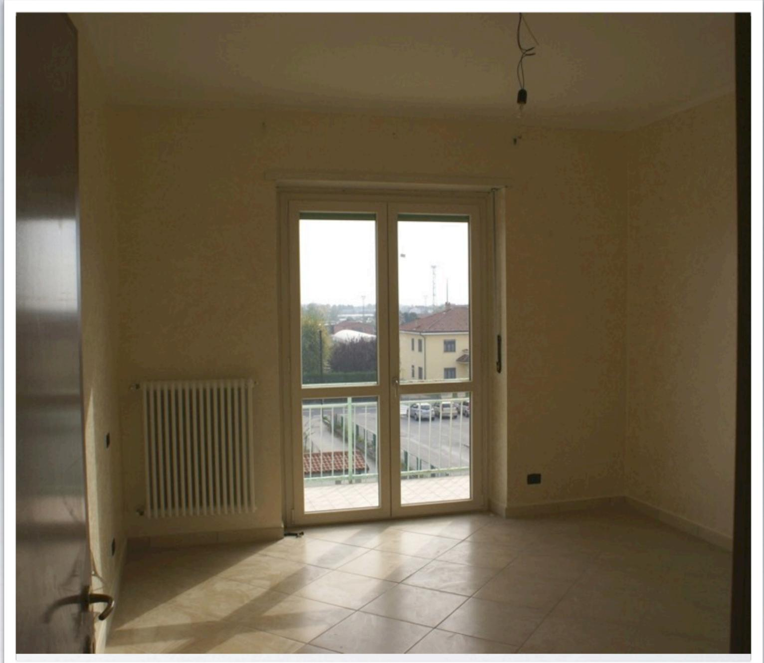
SERRAMENTI PVC, profilo VEKA 70 mm, vetrocamera 4/18/4, basso emissivo con gas argon, tapparelle in alluminio isolate
