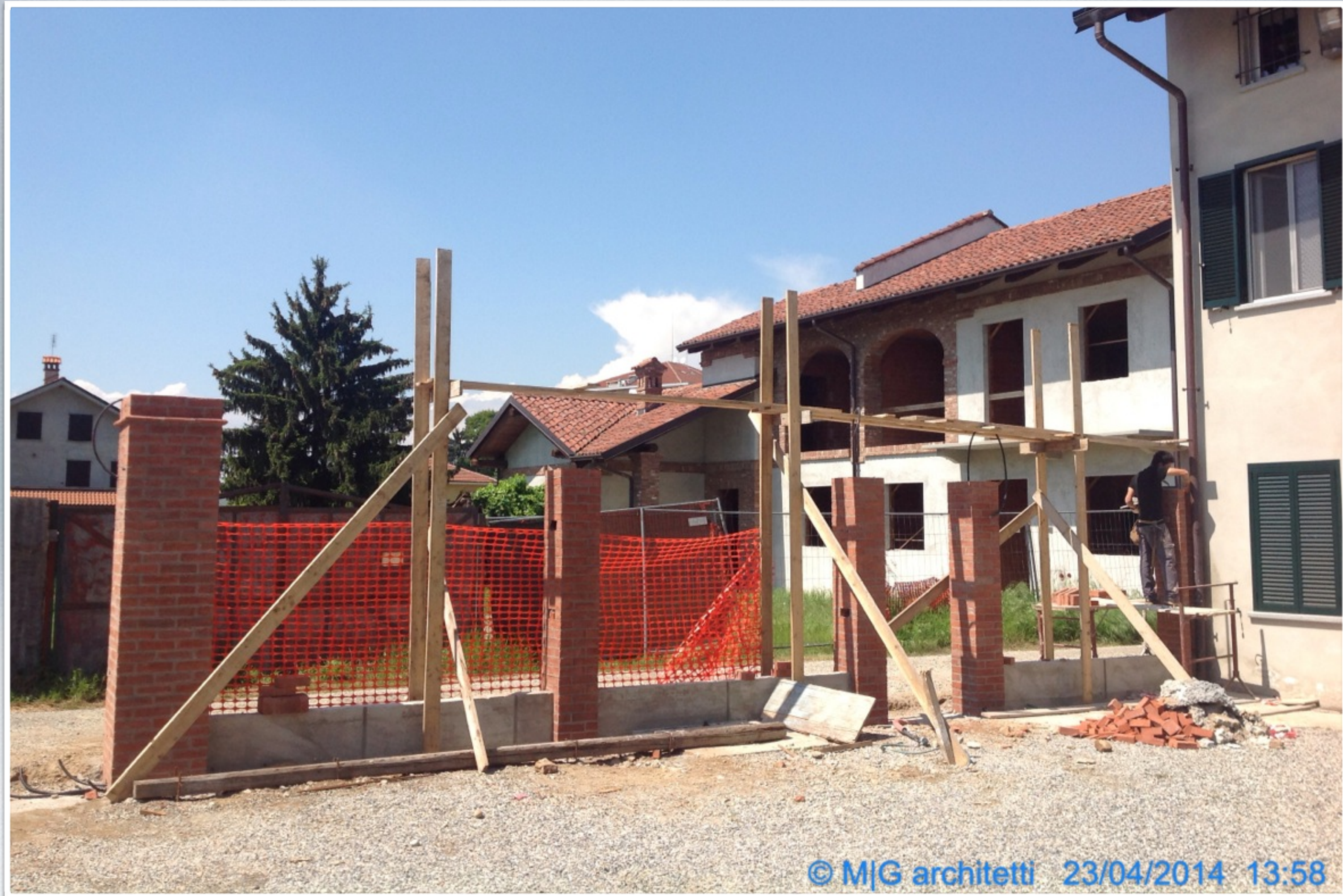
realizzazione pilastri e pilastrini
