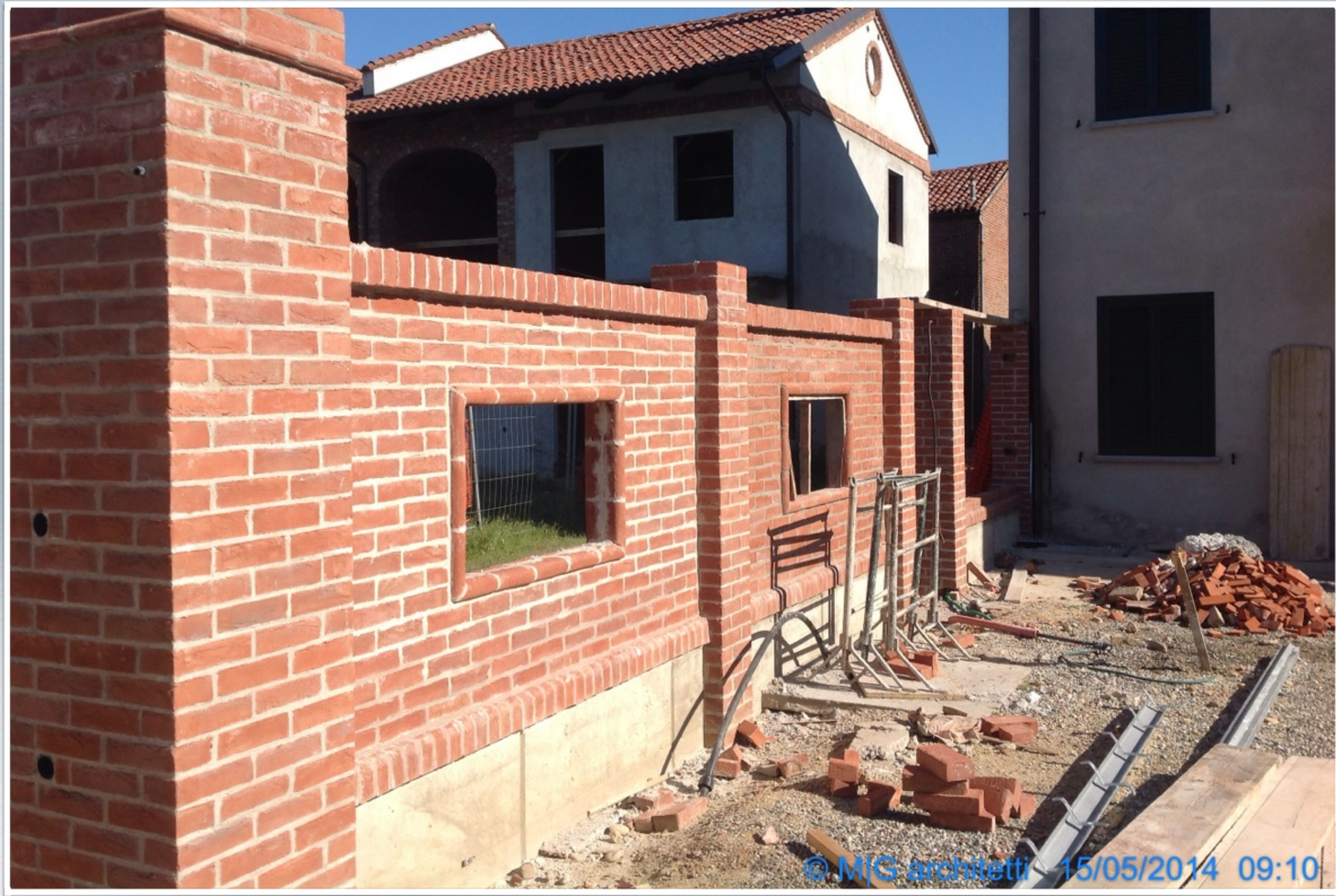
particolare delle aperture di ogni campata
